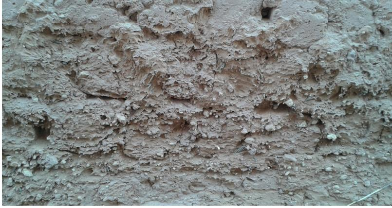
الصورة رقم (2): تبين ظاهرة التحرشف تفتيت المواد الأصلية لمكونات البناء تحت تأثير الحرارة
