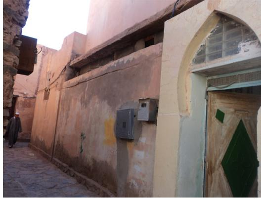
الصور رقم 11-10-09: توضح سوء توصيل الوسائل الحديثة واستعمال الاسمنت
