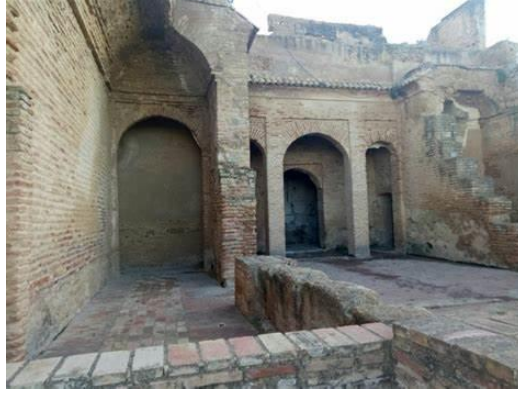
الصورة 2 قصر سيدي أبي مدين بتلمسان
