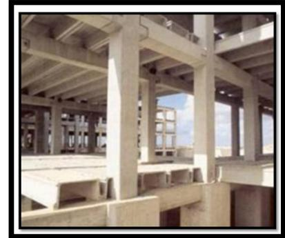
Fig. Image sur chantier « plancher nervuré »
