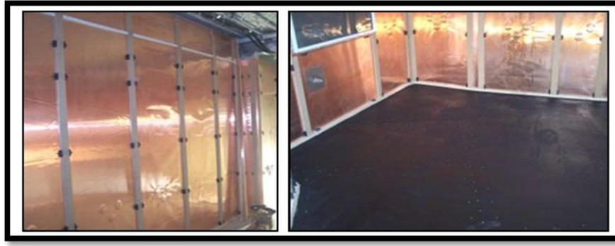
Fig. : Blindage radiofréquence en cours de réalisation
