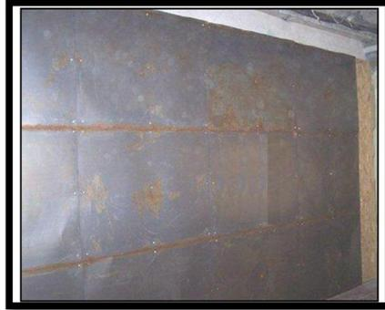
Fig. pose du blindage magnétique
