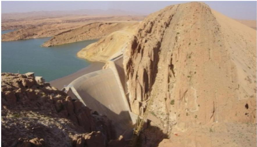
**Fig N°05 : Barrage BREZINA Barrage poids –voute
