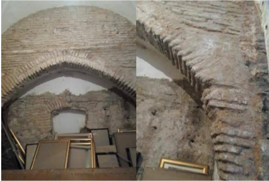
الصورتين 07/06: طريقة وضع الآجر أثناء بناء العقد المنكسر الحدوي بتقنية الأديّة والشناوي المثال مأخوذ من دار مصطفى باشا.
