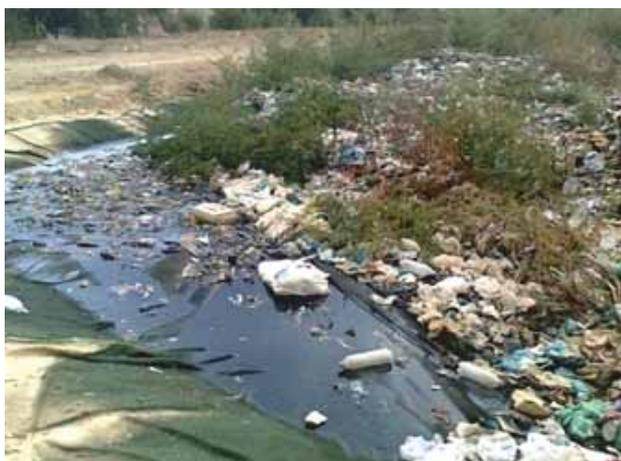
Figure 4 : l'accumulation des lixiviats dans le casier.
