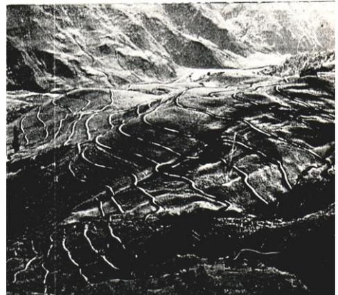
Fig. 3 Réseau de banquettes après une pluie
