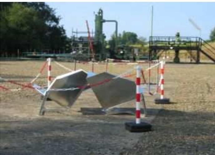
Fig. 12 : Réflecteurs installés dans la zone de stockage de gaz à proximité des puits pour garantir des points de mesure dans le futur
