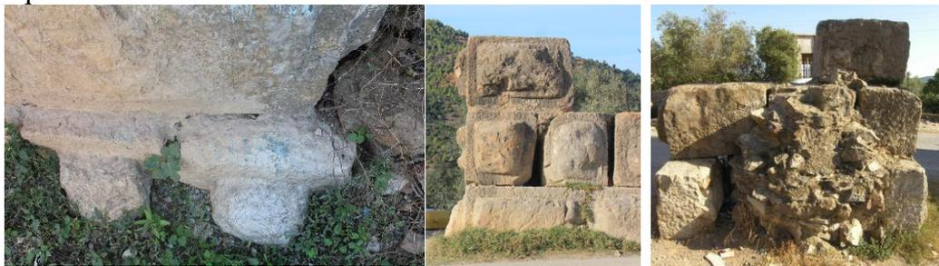
Figure 5. Parement des piliers du pont aqueduc de Tihnaine à Ifren (Toudja). *Opus quadratum* avec bossage à l'extérieur et le blocage en *opus caementicium* à l'intérieur.
