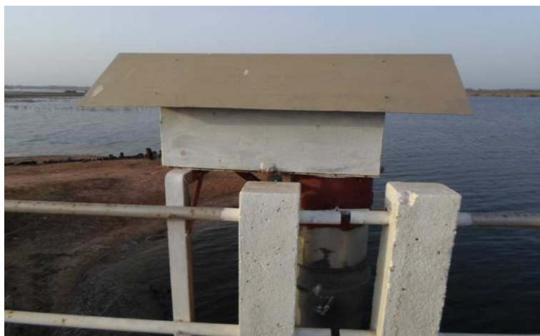
Photo 1 : Boîtier fixé sur le pont du site de Baïla dans lequel le capteur est logé
